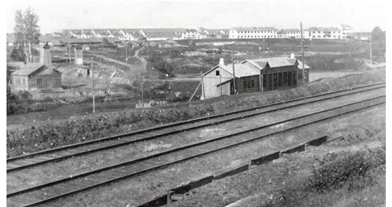
▶ Панорама рабочего поселка Электровозстрой со стороны Акри. 1933–1938 гг.
